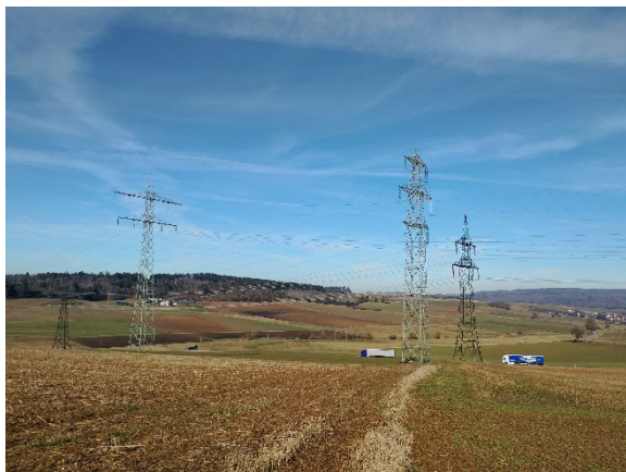
Nördlich der geplanten PV-Anlage erstrecken sich mehrere Hochspannungsmasten.
